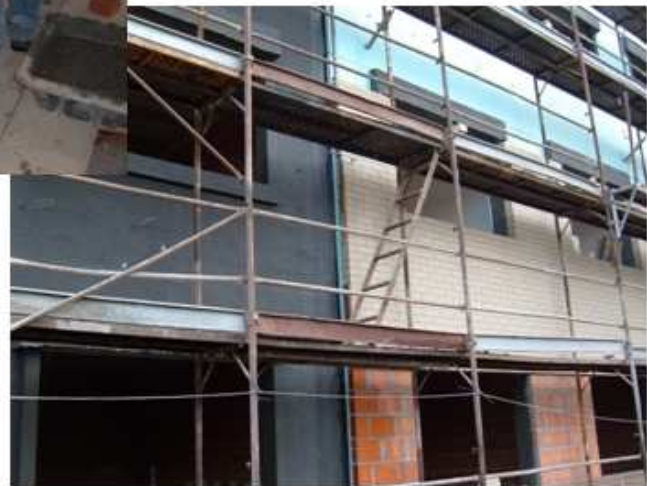
Isolamento da fachada do Edifício
