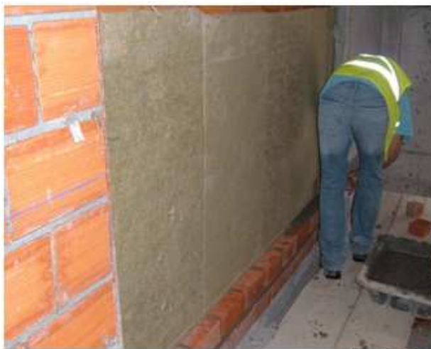
Lã de rocha nas paredes de meiação
